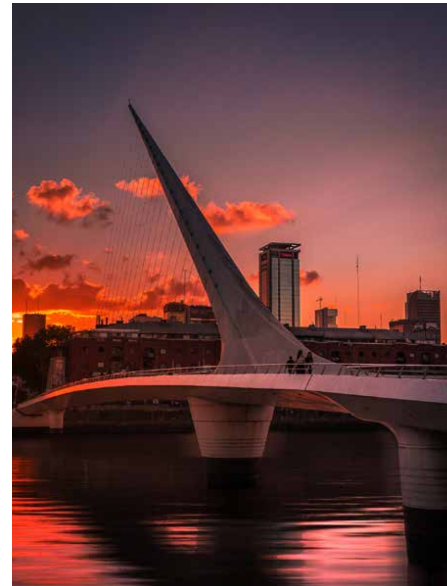
Puente de La Mujer de Santiago Calatrava en Buenos Aires
