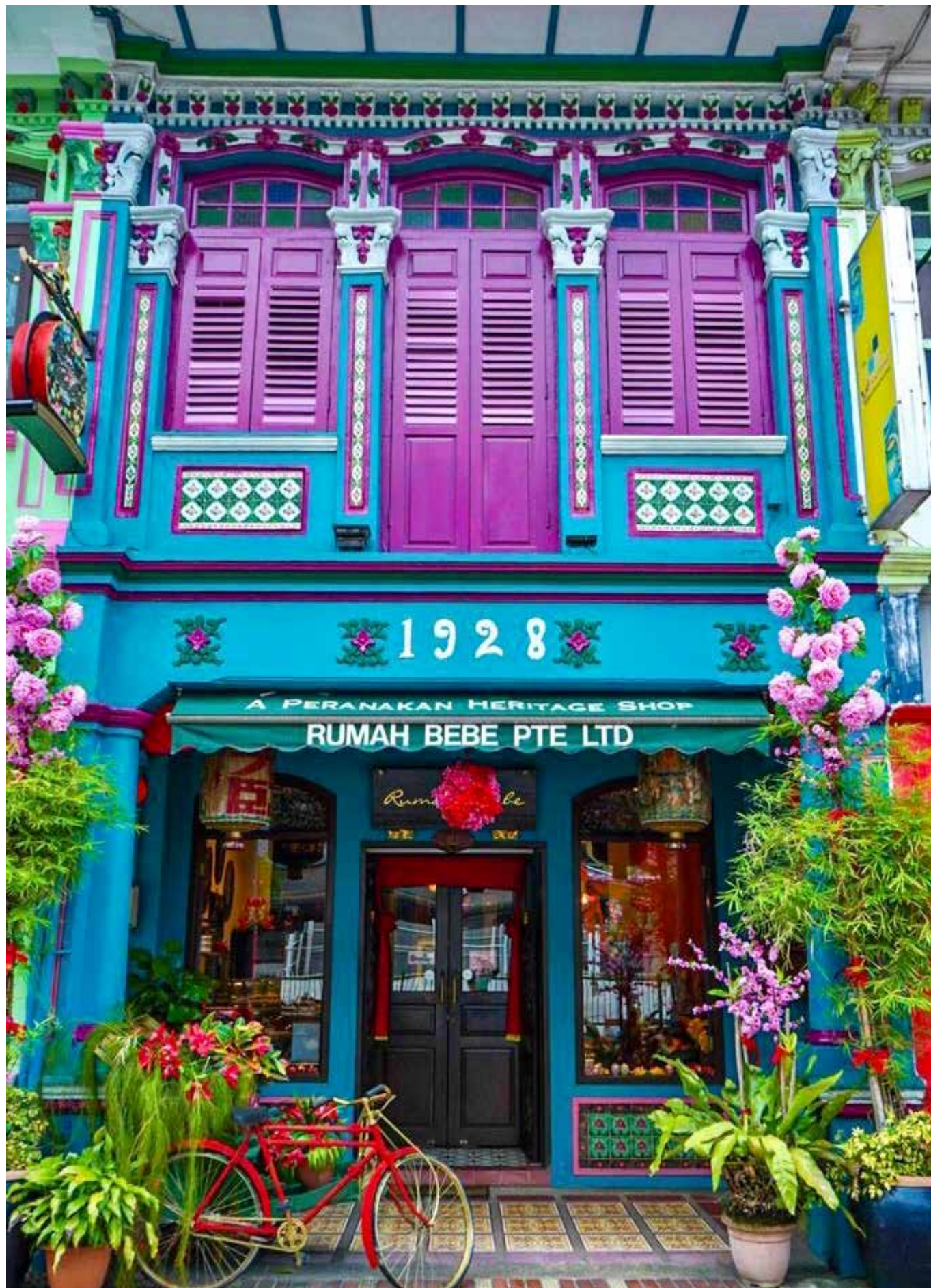
Fachada comercial en Peranakan
