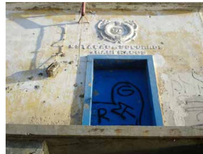
Estação de Socorros a Náufragos, más conocida como Casa del Capitán.
