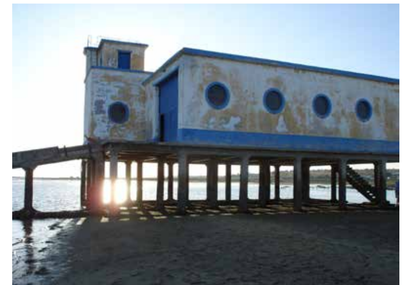
La caseta de salvamento se levanta sobre pilares de hormigón, a modo de palafito antiguo, en la playa de Fuzeta.
