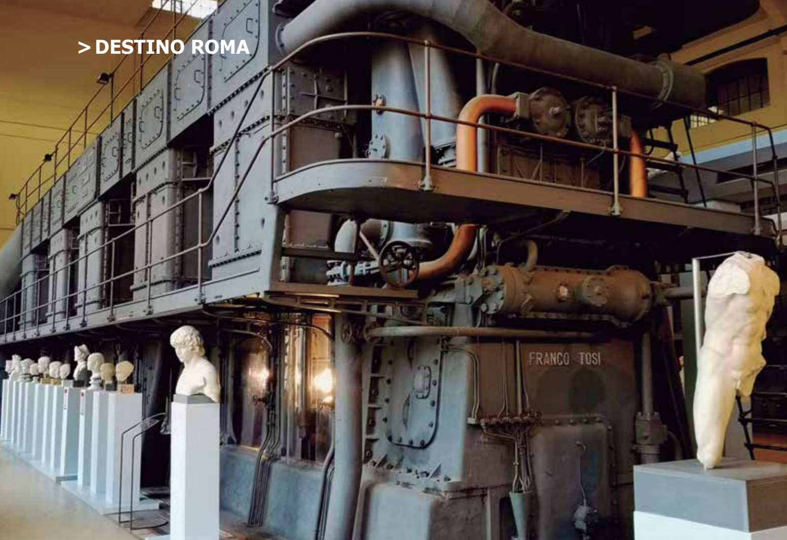
▲ Maquinaria de la Central Eléctrica de Montemartini en contraste con esculturas de la antigua Roma.
