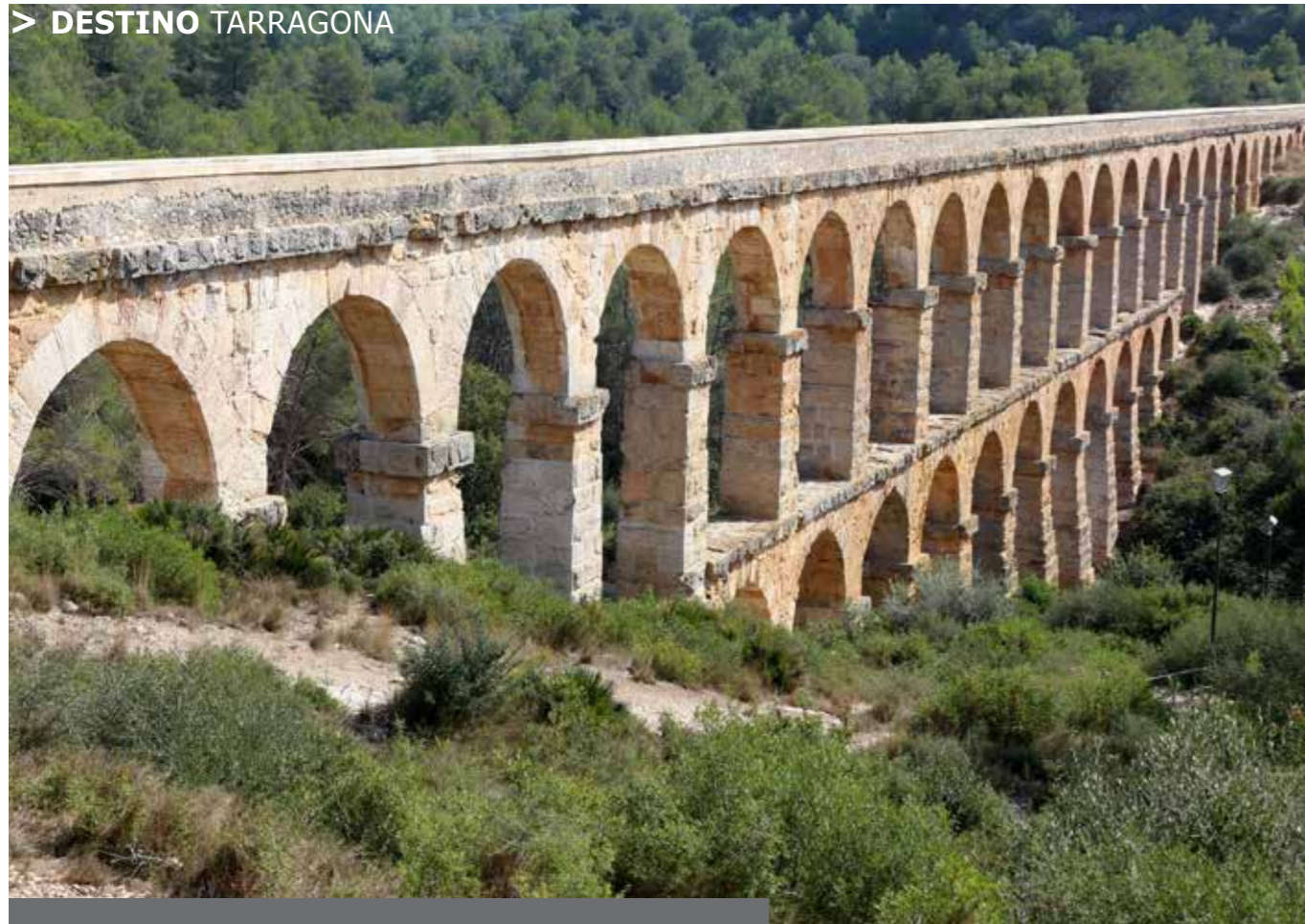
▲ Pont del Diable o acueducto romano de Les Ferreres. / Foto Txell Roig
