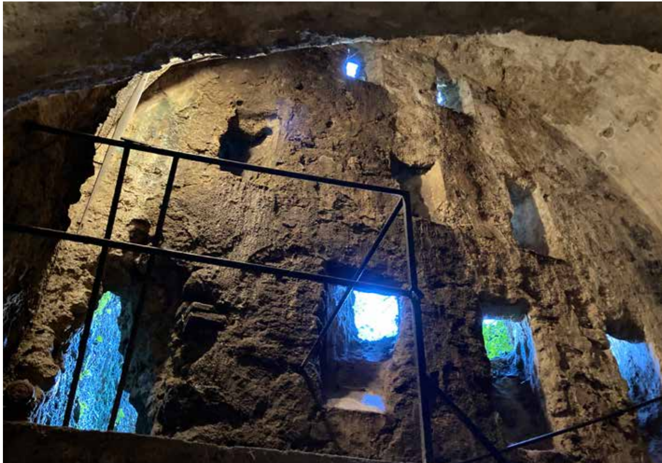
La mina de agua de la Casa del Rey Moro es una de las grandes obras de ingeniería hidráulica construidas en el Reino Nazarí durante el siglo XIV. Extraía agua del río para suministro de la población en caso de asedio.
