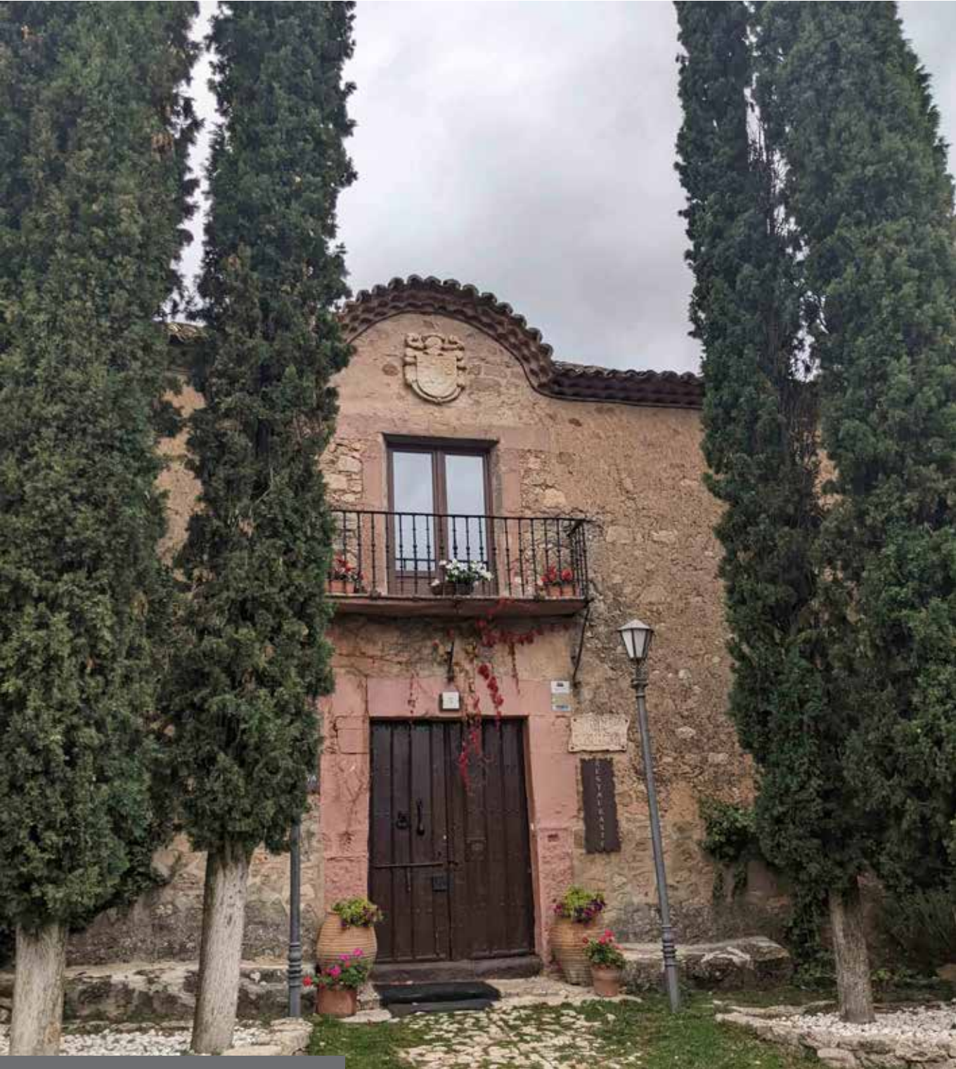
Casa Palaciega El Cuartel, en Medinaceli.
