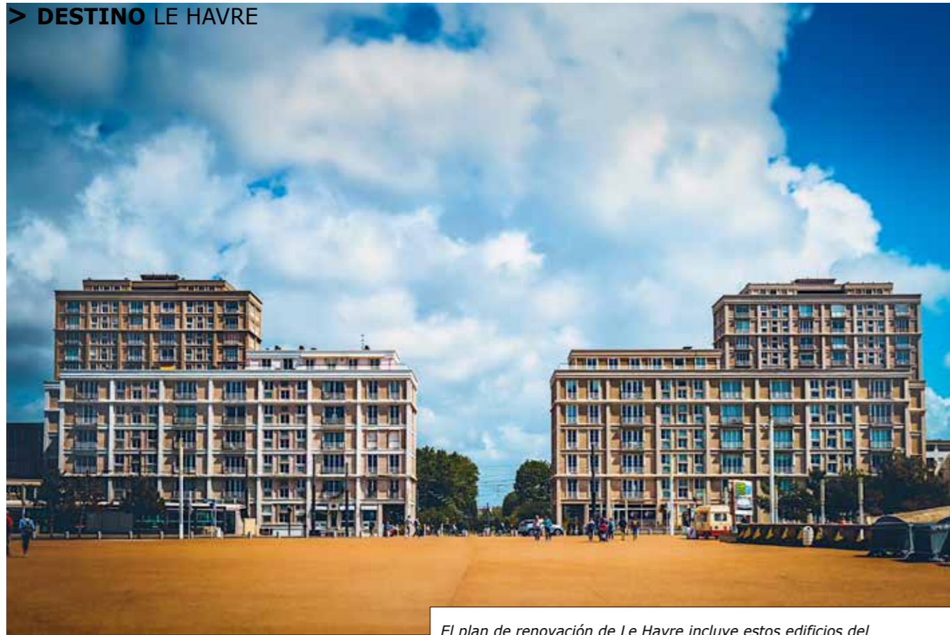
El plan de renovación de Le Havre incluye estos edificios del ayuntamiento, que además forman una puerta de entrada a la ciudad.
