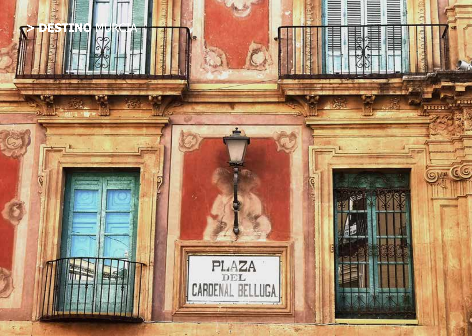
▲ Detalle del palacio Episcopal en la Plaza del Cardenal Belluga. ► Torre renacentista de la catedral de Murcia. ▼ Fachada frontal de la catedral de Murcia.
